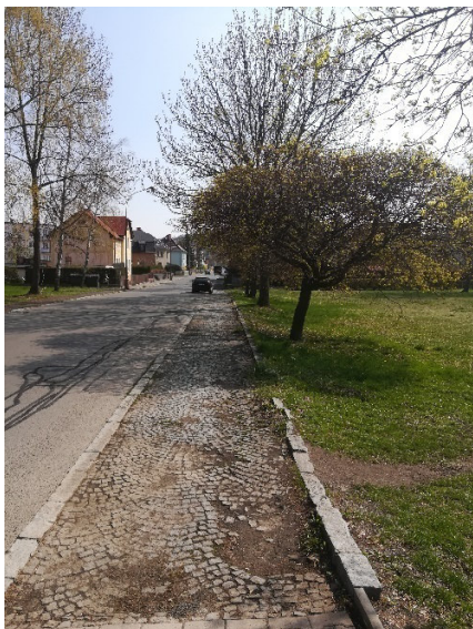
Rozpadající se chodník z žulové kostky při severním okraji
